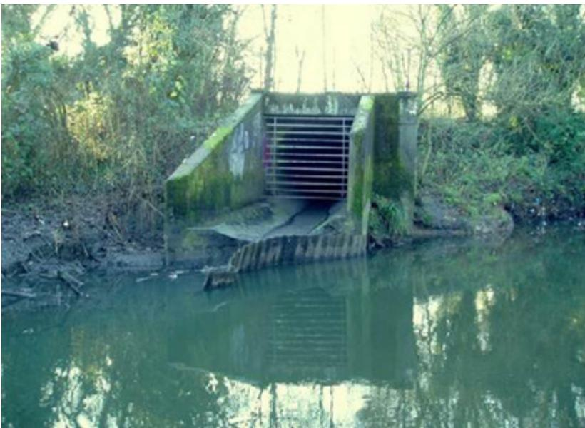
Collecteur d'eaux pluviales souterrain (tuyau en béton)
