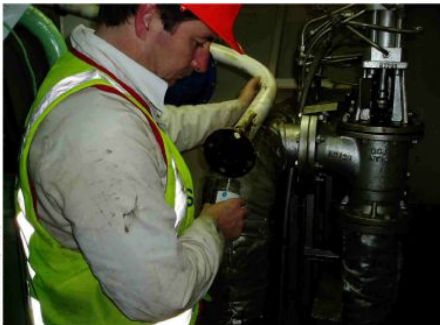
41. Toma de muestras en la sala de máquinas.
