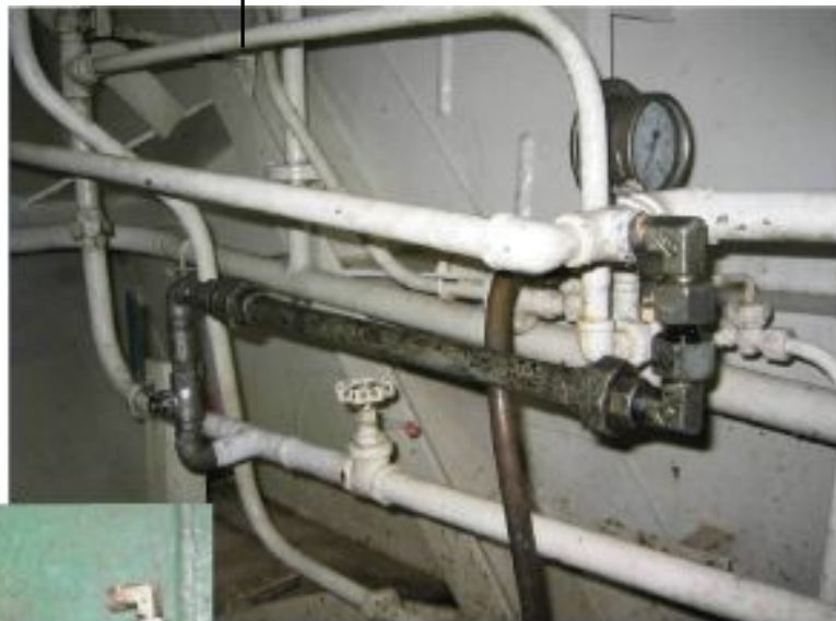
14. Tubería soldada utilizada para poner en derivación el separador de agua e hidrocarburos.
