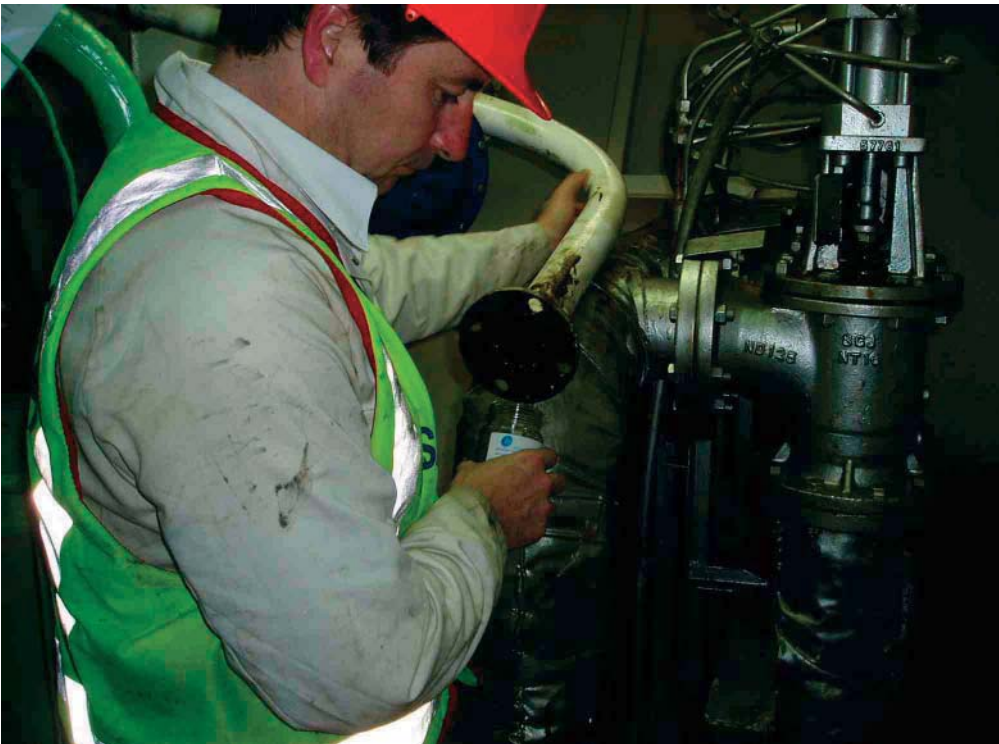
41. Prélèvement d'échantillons dans la salle des machines.
