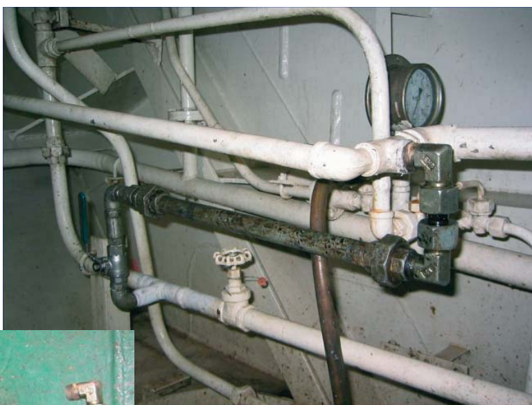
14. Tuyauterie de dérivation fabriquée pour contourner le séparateur d'eau et d'hydrocarbures.
