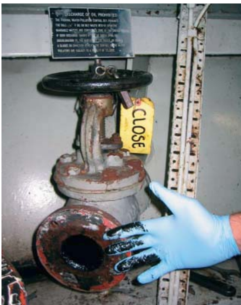
10. Résidus d'hydrocarbures trouvés à l'intérieur des vannes de décharge à la mer.
